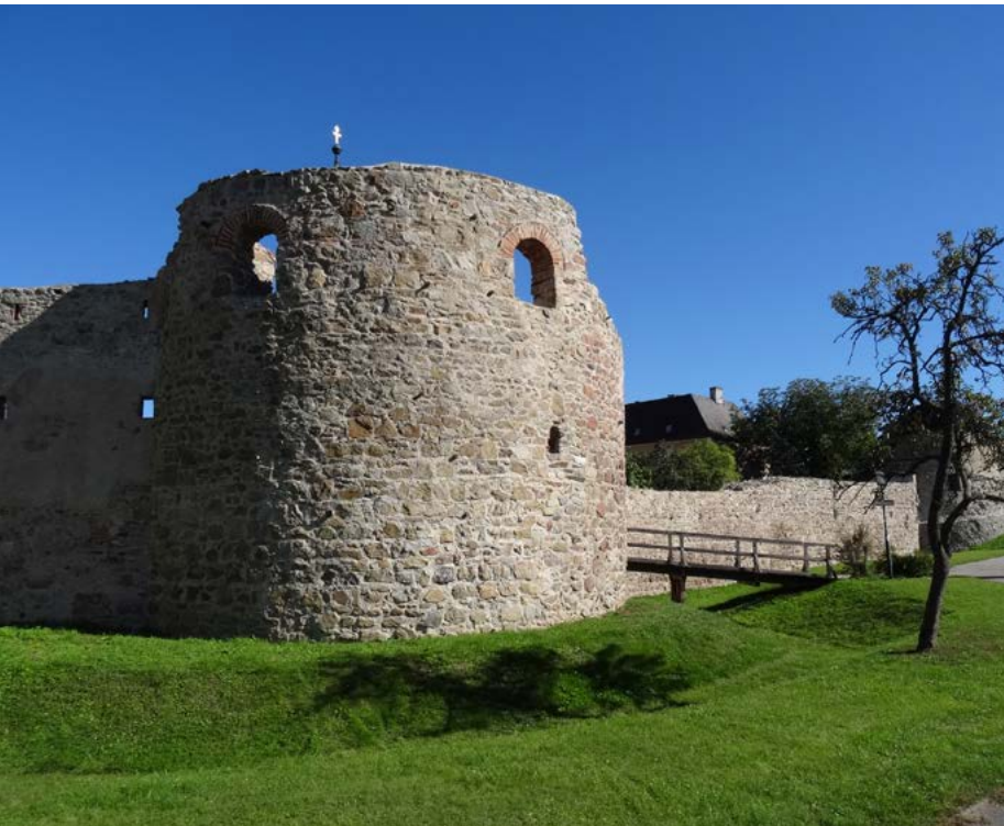
Kastells Favianis/Mautern. In der Spätantike wurden die Kastellmauern massiv verstärkt und die Eck- und Zwischentürme zu weit vor die Mauern vorkragenden Fächer- beziehungsweise Hufeisentürmen umgebaut, die bessere Verteidigungsmöglichkeiten des unmittelbaren Kastellvorfelds erlaubten. Die Wehranlagen wurden im Mittelalter weiterverwendet. (Foto: BDA, R. Ployer)
